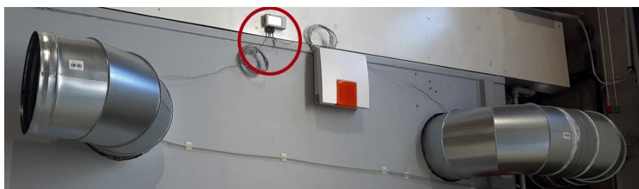
FIGURE 33 VMP DFST ALDES VEX 308 installée dans une salle de formation (vue extérieure)
