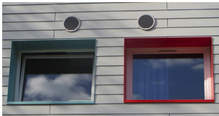
FIGURE 24 Façade extérieure après travaux de rénovation : ITE avec bardage bois + intégration d'une VMP DFST sans remplacement des menuiseries
