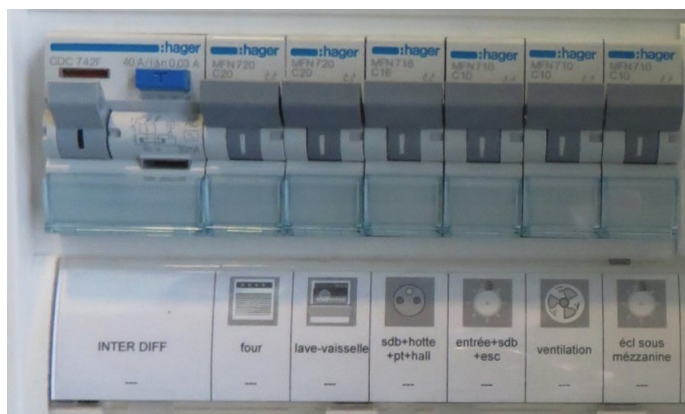
FIGURE 22 Intégration d'un disjoncteur sur tableau électrique en résidentiel (à gauche) et tableau spécifique regroupant 10 unités en tertiaire (à droite)
