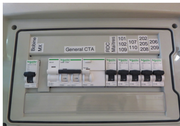
FIGURE 22 Intégration d'un disjoncteur sur tableau électrique en résidentiel (à gauche) et tableau spécifique regroupant 10 unités en tertiaire (à droite)
