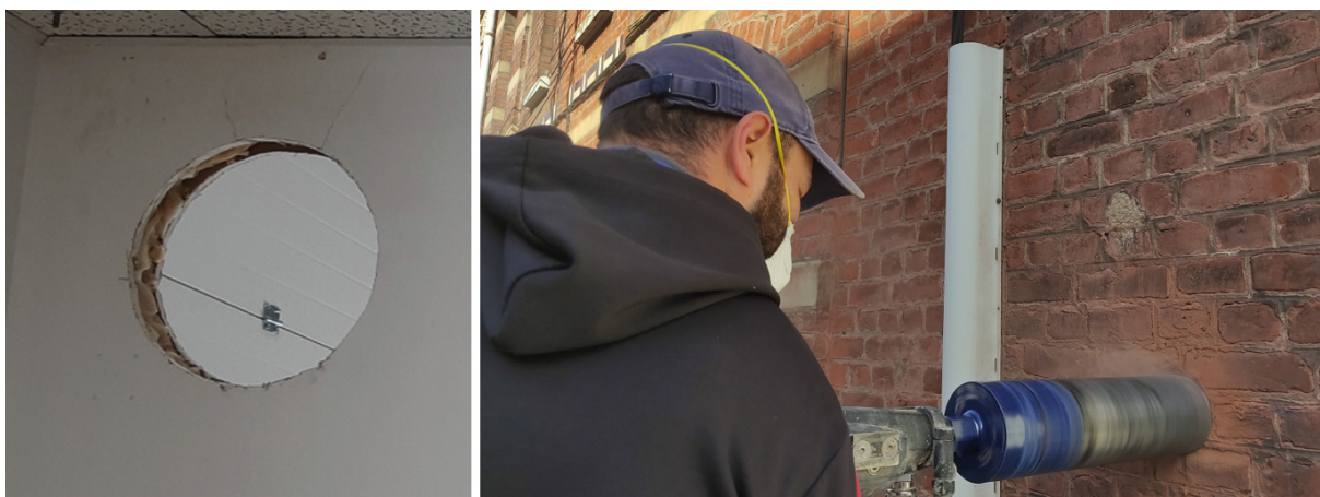
FIGURE 19 Percement en cloison (à gauche) et en façade (à droite)
