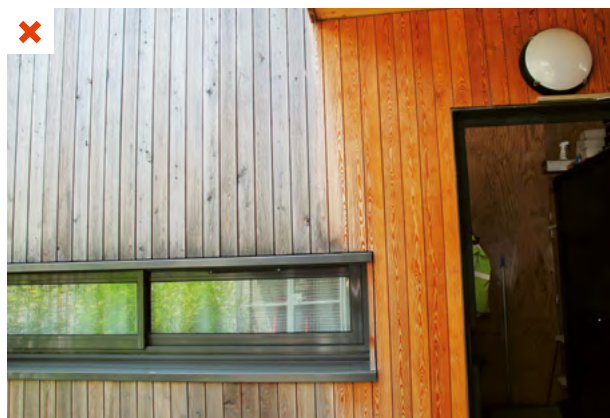
Bois qui grise non uniformément à cause d'accidents de façades. ©AQC
