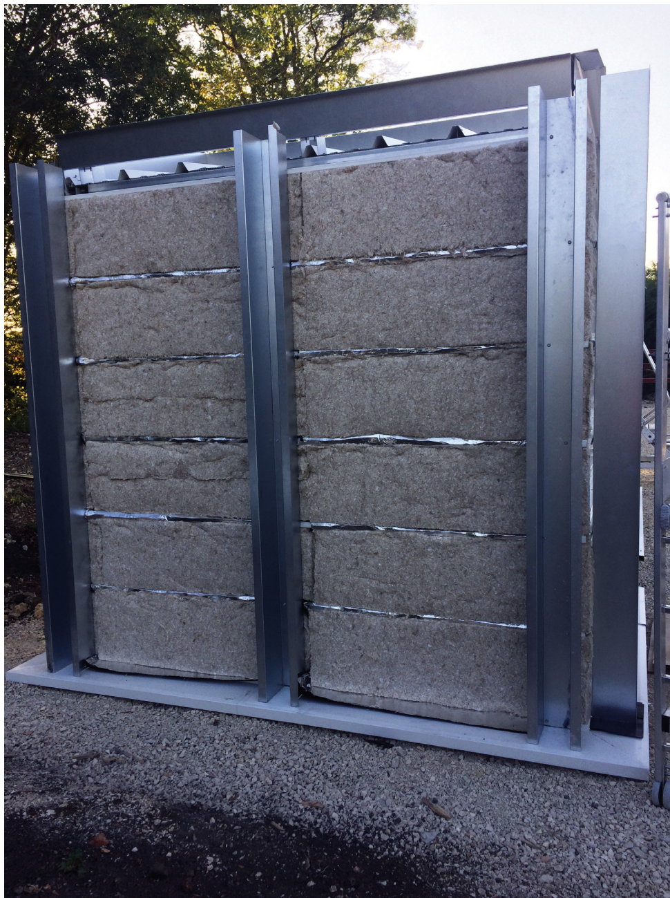
PHOTO 3 Face latérale 1 avant pose des pare-pluie
