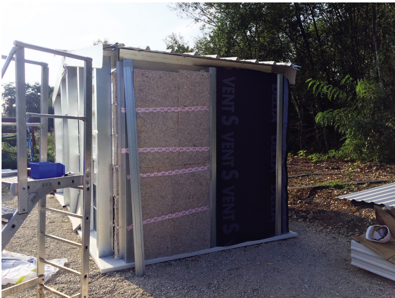
PHOTO 5 Face latérale 2 après pose des pare-pluie
