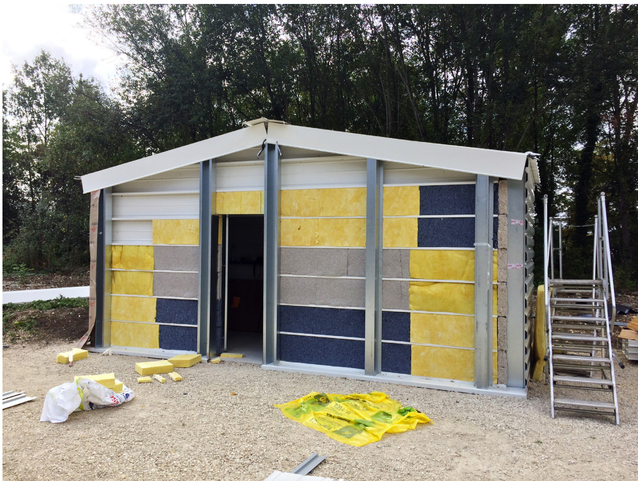
PHOTO 2 Face avant du démonstrateur avant pose des pare-pluie
