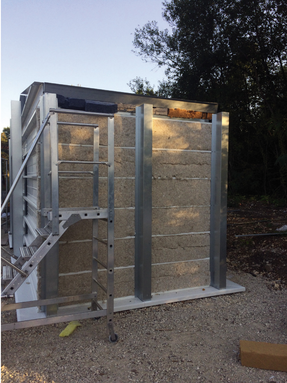
PHOTO 4 Face latérale 2 avant pose des pare-pluie
