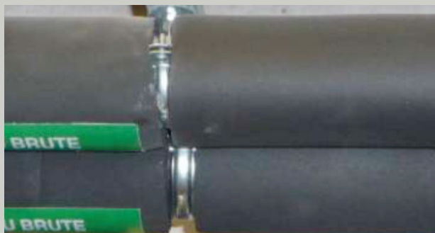
Discontinuité de l'isolant au niveau des accroches - construction d'une école dans le Loiret
