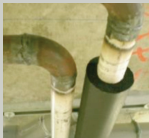
Espacement entre les conduits est très insuffisant pour permettre un calorifugeage satisfaisant (opération de construction de logements sociaux à Tours)
