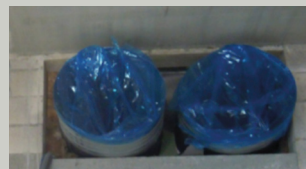
Réseaux installés bouchés
