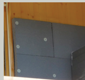
Accroches d'isolant avec chevilles, ITE (Chalette sur Loing)
