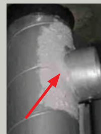
Absence de bande de recouvrement
