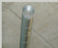
Conduits bouchonnés
