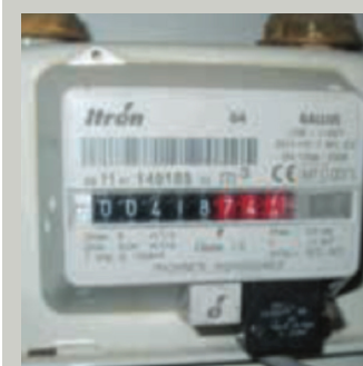
Compteur gaz à impulsion, source COSTIC
