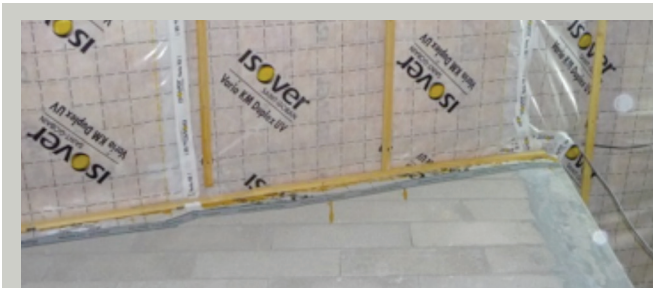
Défaut d'étanchéité : le collage de la membrane sur la partie maçonnée n'est pas assez soigné. Il aurait été nécessaire de mettre en œuvre un primaire d'adhésion permettant de préparer la surface à coller puis un large ruban adhésif adapté.
