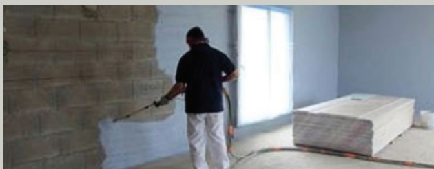
Étanchéifier le mur maçonné par enduit ou par un produit spécifique (type Aérobloc, photo ci-dessus)
