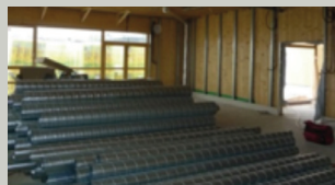
Réseaux entreposés exposés à la poussière
