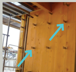
Accroches d'isolant avec équerres (Chalette sur Loing)
