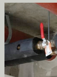
Vannes sans réhausseur de levier - construction de logements sociaux
