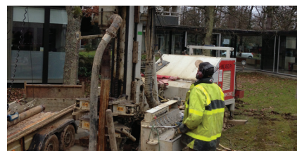
Forage pour l'installation de 3 sondes géothermiques dans le cadre de la rénovation d'un bâtiment du BRGM
