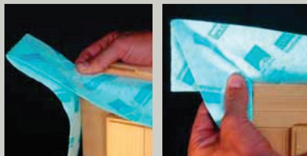
Membrane flexible munie d'une bande auto-adhésive à coller sur le dormant
